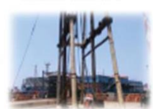
Grúa de izaje
